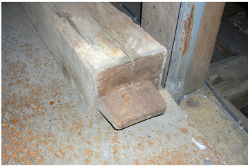
Fig. 1 : Exemple d'assemblage par tenon et mortaise
